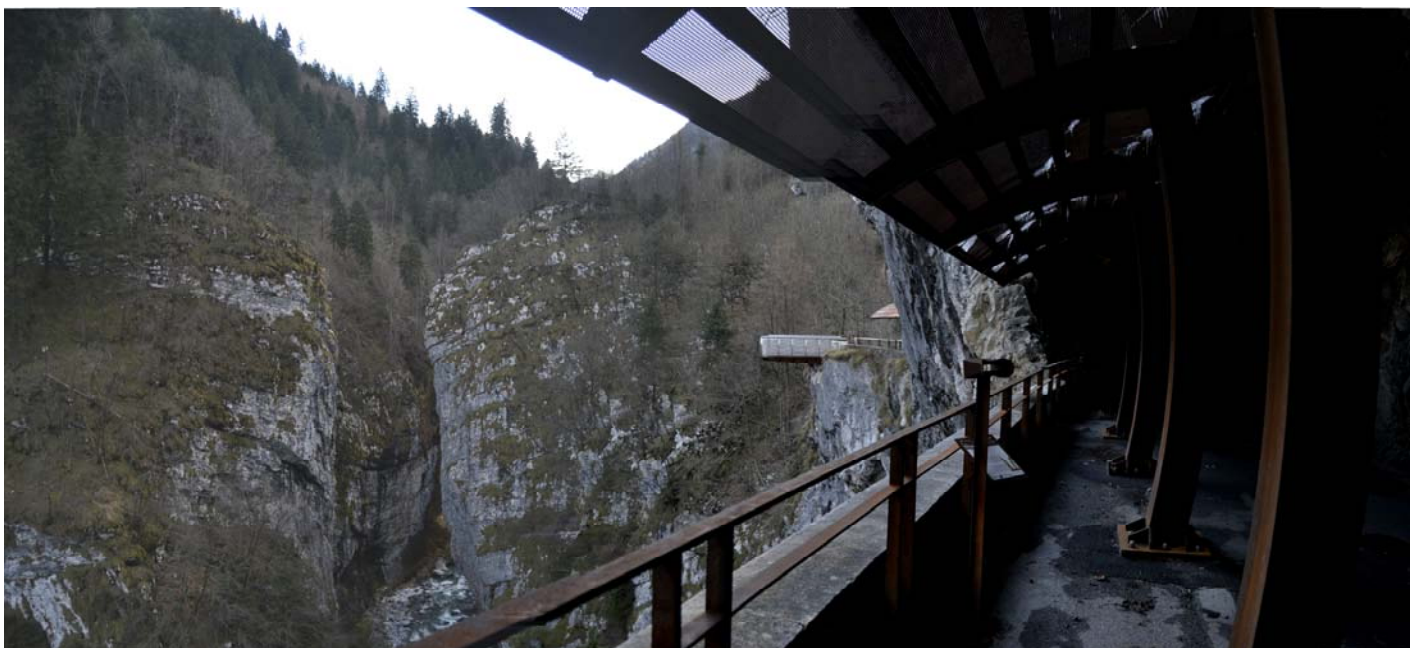
Fig. 4 Il percorso geologico offre attraverso un balcone proteso sul vuoto una suggestiva visione della forra ed è dotato di strutture protettive contro la caduta di sassi dall'alto.
